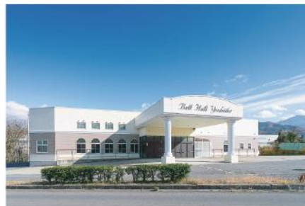
高社山がバックにそびえ、景観の良い「ベルホール吉池 山ノ内会館」。オープン以来、地域の人々に愛されている
